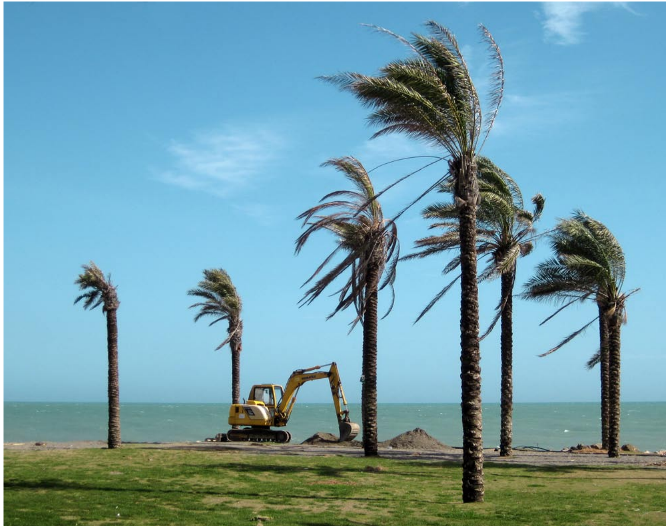
240 Torremolinos / Palmen und Bagger
